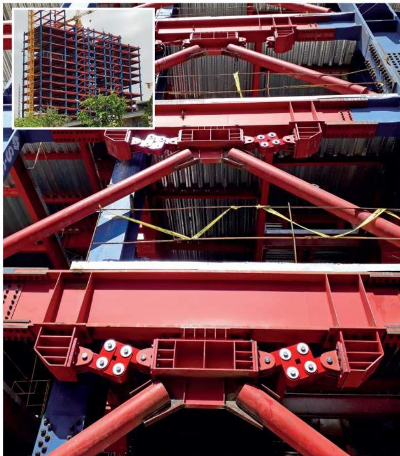
ساختمان مرکزی بانک پاسارگاد دارای ۲۵ طبقه می‌باشد که مجہز به سیستم میرایی اصطکاکی دورانی **DAMPTECH** می‌باشد. سازه این ساختمان قاب خمشی فلزی ویژه بوده و میراگرهای آن نصب شده است. مساحت این پروژه در حدود ۵۰ هزار متر مربع می‌باشد.
